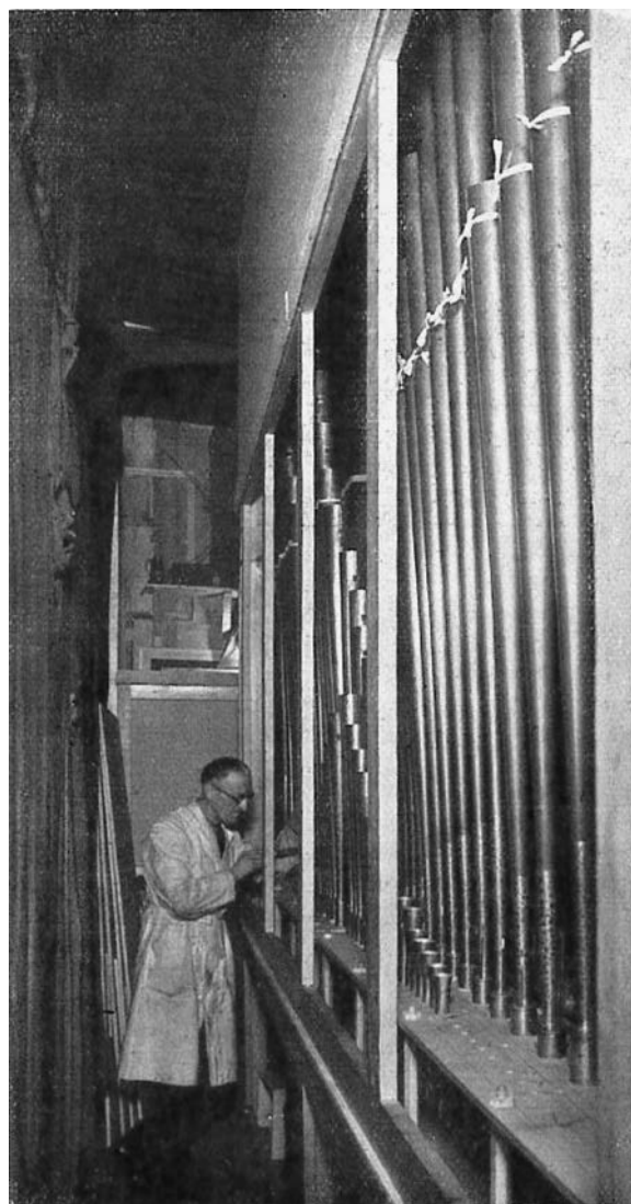
10. L'illustration, op. cit. , p. 22. Meuble contenant les 420 tuyaux des deux claviers de récit et de solo. Un orgue classique exigerait 1447 tuyaux pour le même nombre de jeux.
